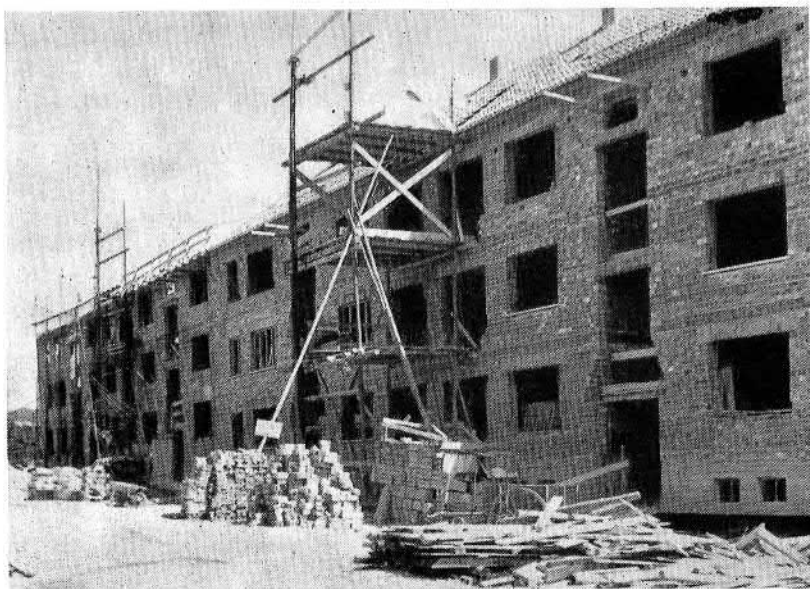
Der 1. Wohnblock der AWG „Ernst Thälmann“ im Bau
