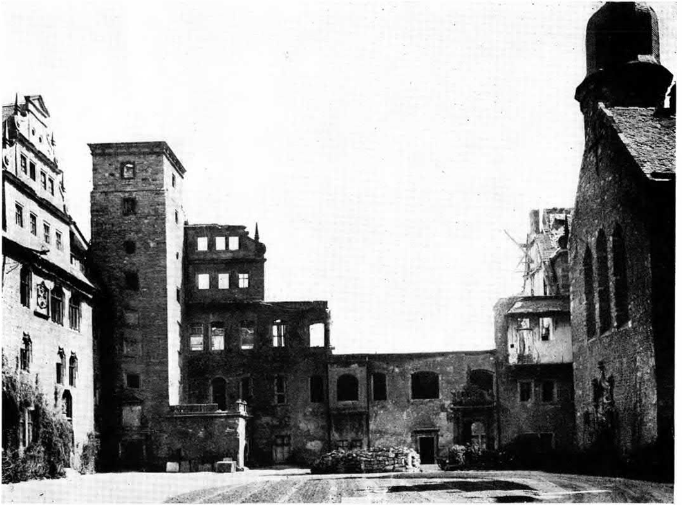
Im 2. Weltkrieg wurde der Ostflügel des Schlosses durch mehrmalige Terrorangriffe anglo-amerikanischer Bomber fast völlig zerstört.
