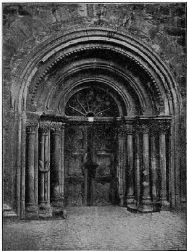
Das große Portal der Neumarktkirche.
