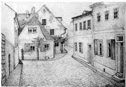
Bild 10 Ecke Hälterstraße-Unteraltenburg (zum Teil abgeriffen)
