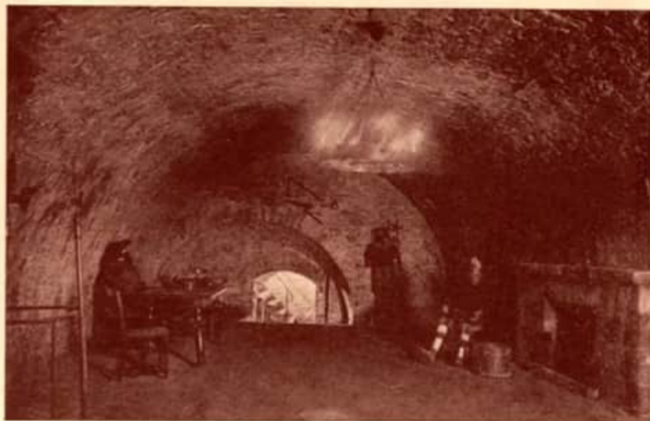
Wachraum der Landsknechte im unterirdischen Gewölbe des Geleitshauses
