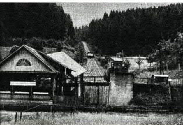
Abb. 4 Talstation Obstfelderschmiede mit Gleis für Güterbühne und anschließender Drehscheibe zum Übergang auf die Schwarzatalbahn.
