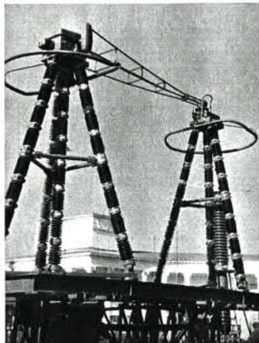
Einen gigantischen Schalter zeigt dieses Bild. Der neue Spezialschalter für Hochspannung bis zu 500 000 V, der von der Fabrik für Hochspannungsgeräte des Pridneprowsker Sowjets für Volkswirtschaft hergestellt wird, erreicht die Höhe eines zweistöckigen Gebäudes.
