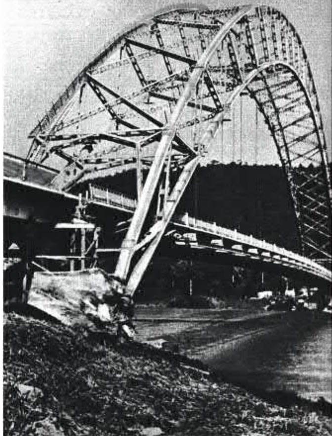
Die Brücke über den Fluß Volta bei Adom, deren Bau im Jahre 1954 begonnen und Ende 1956 beendet wurde
