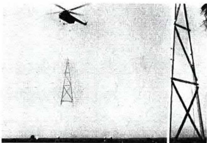
Einfliegen der Teile eines trigonometrischen Punktes
